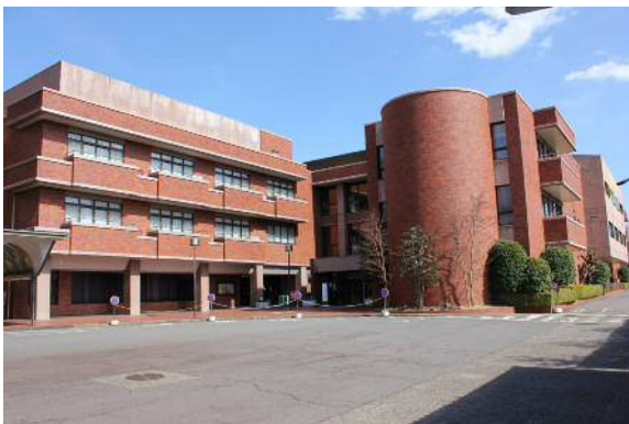
(施設外観写真)
