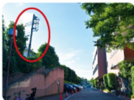
引き込み電柱
